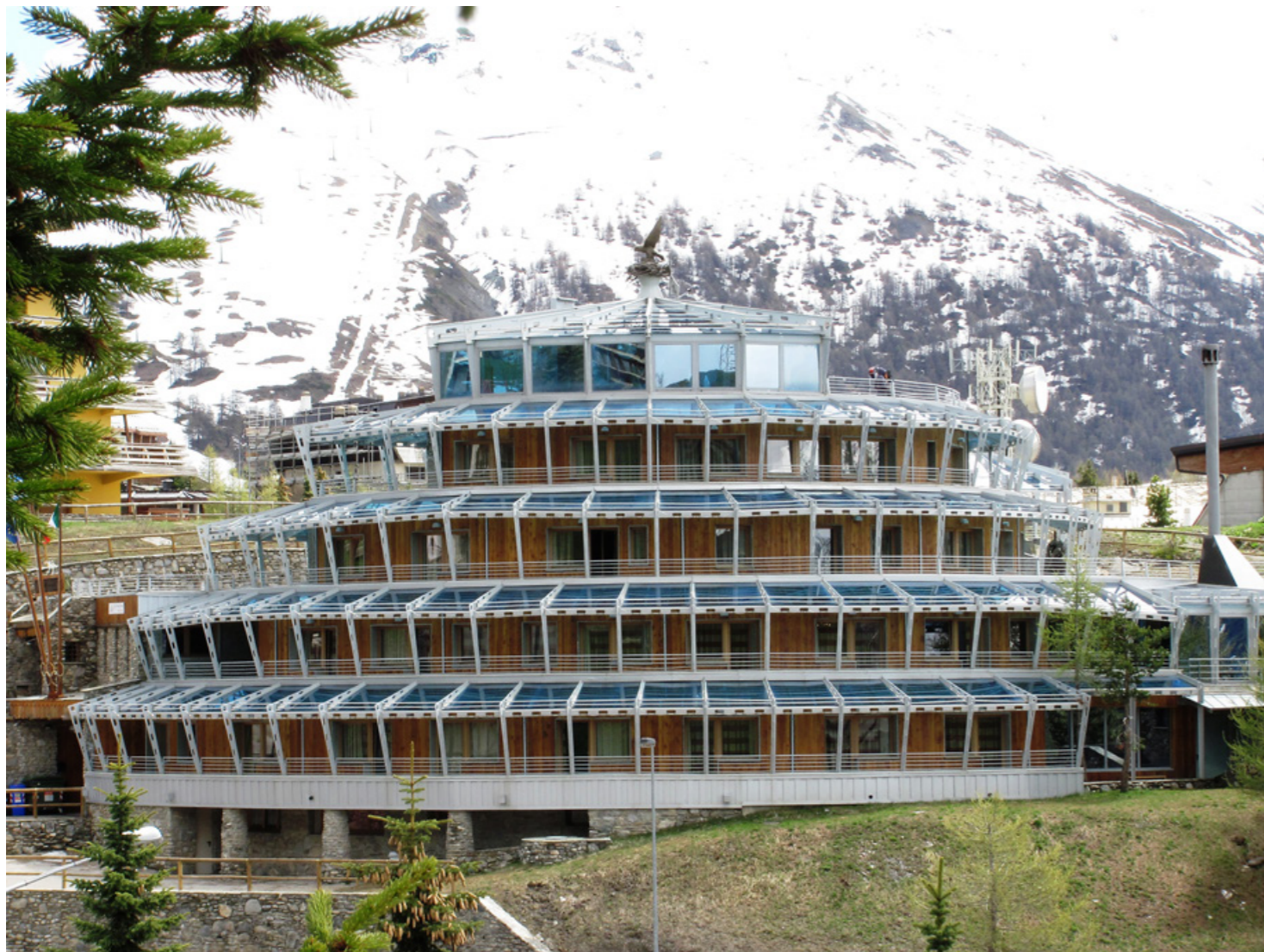
Shakleton hotel - nouvelle construction - hotel ****
