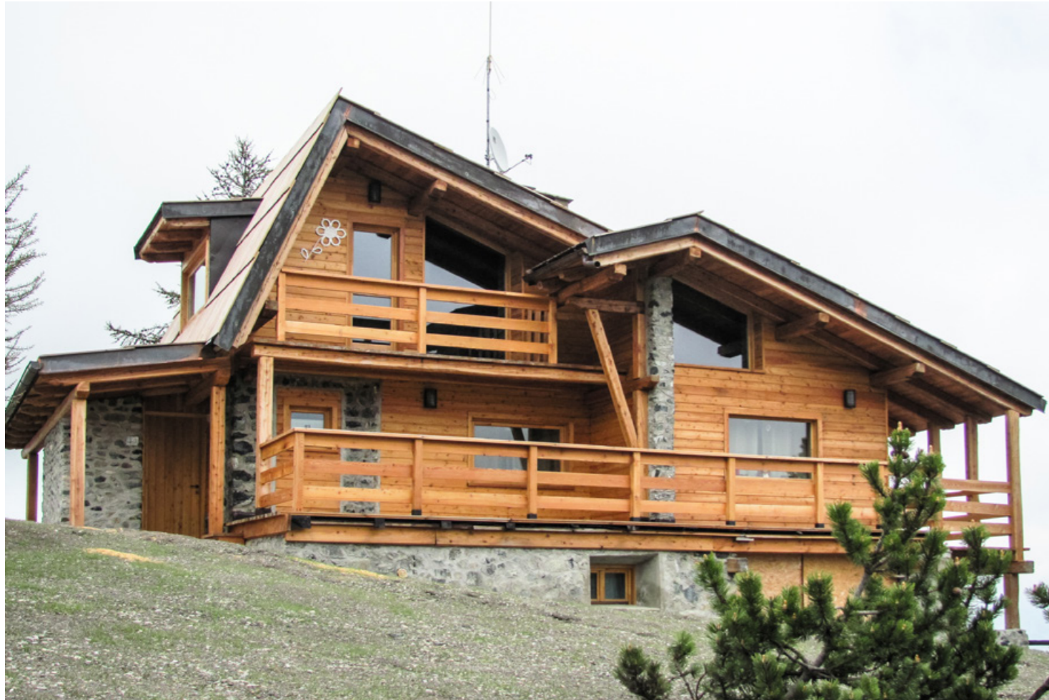
Chalet Fiore - nouvelle construction - résidence unifamiliale
