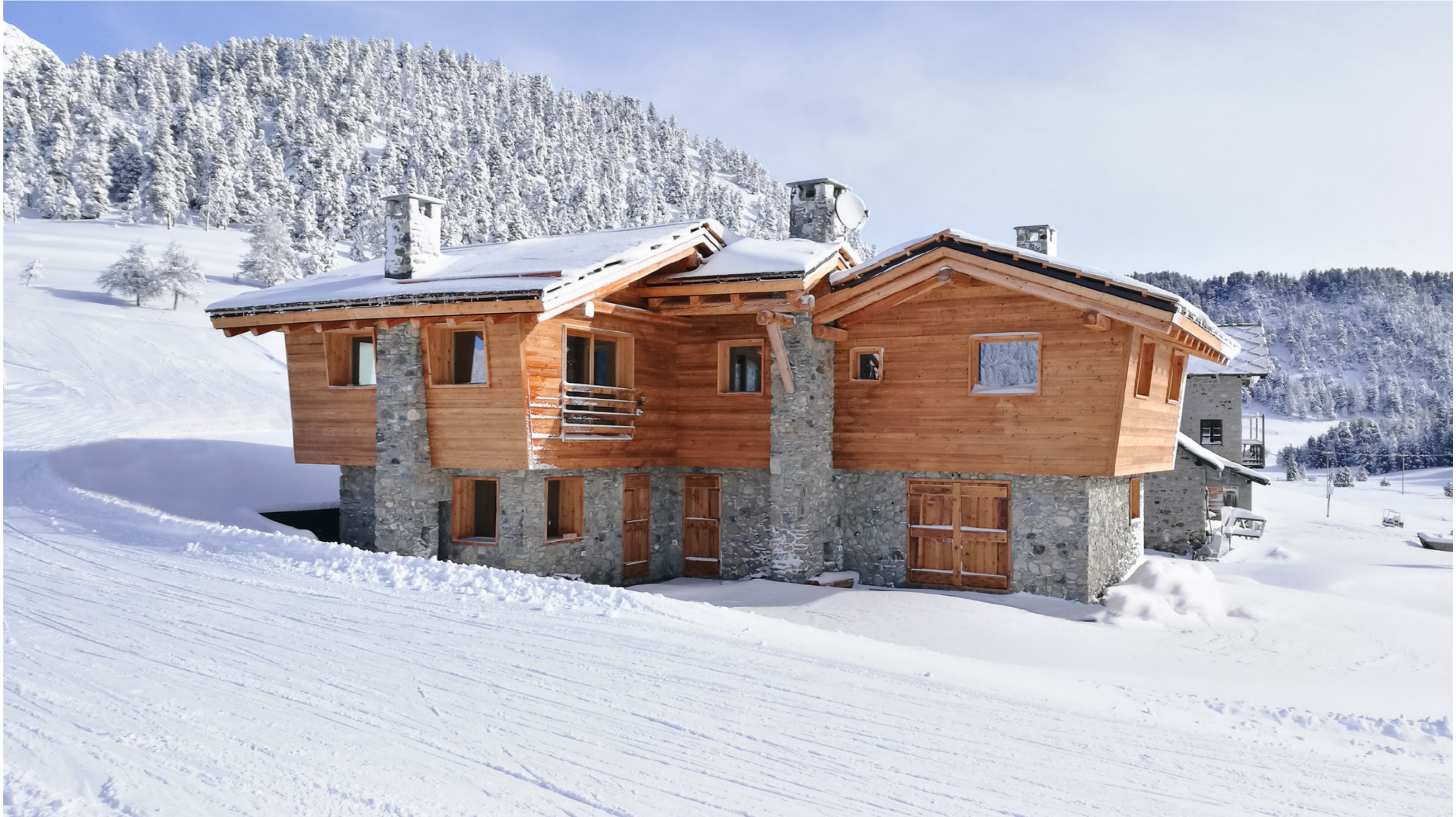
Casa T.V. - nouvelle construction - résidence unifamiliale
