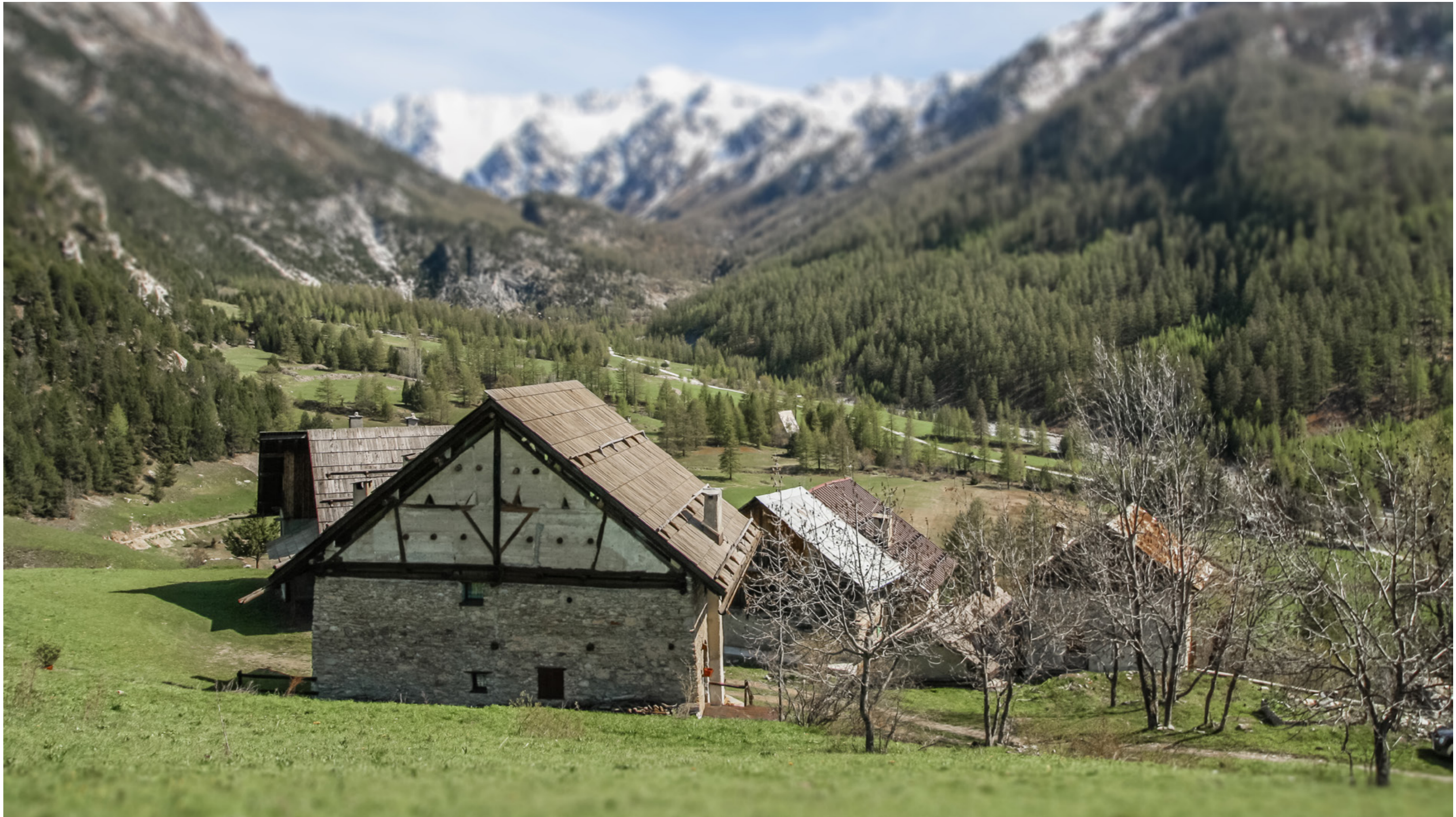
Casa C.F. - rénovation - résidence unifamiliale
