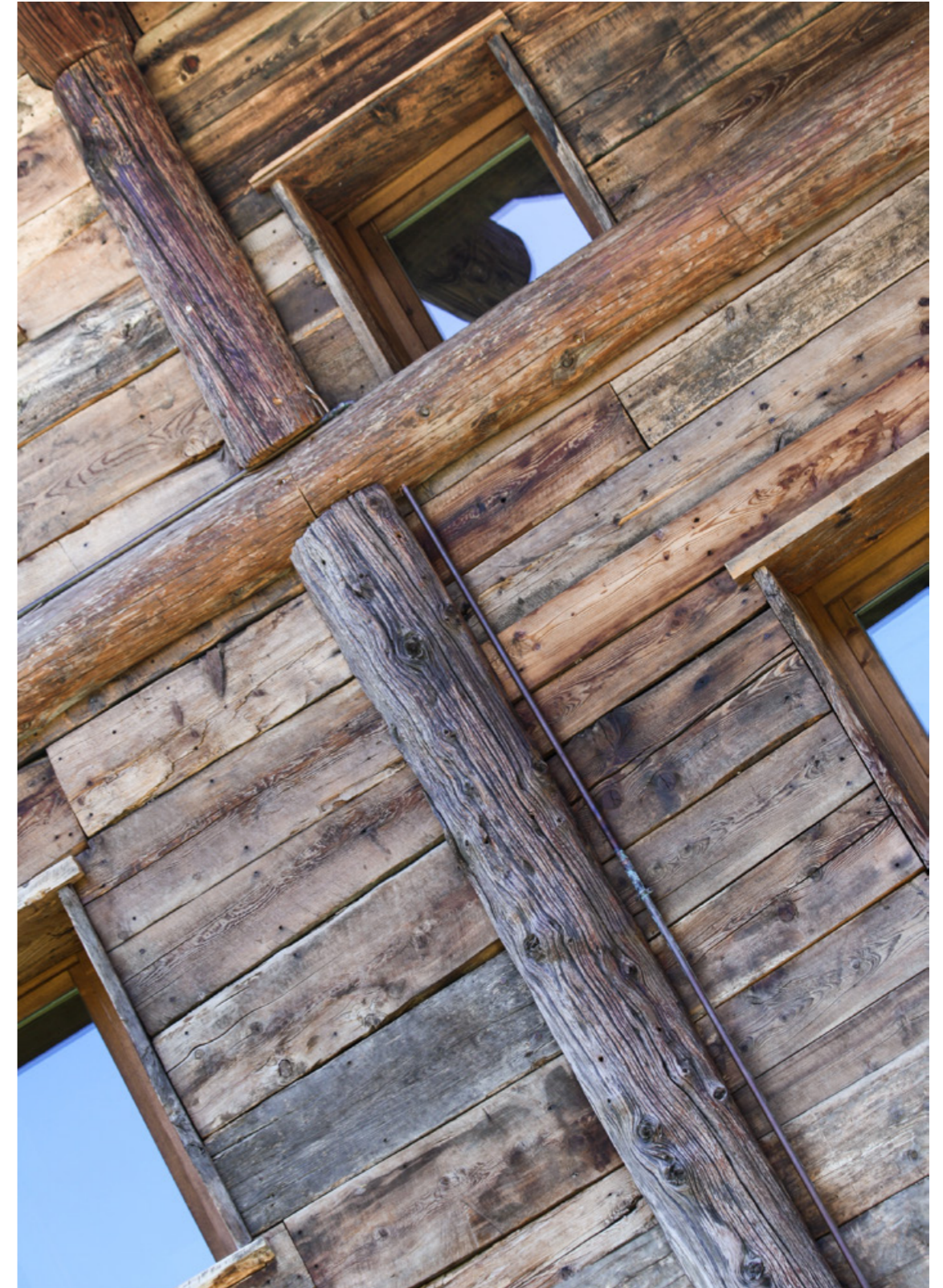
Lou Praije - rénovation - résidence multifamiliale
