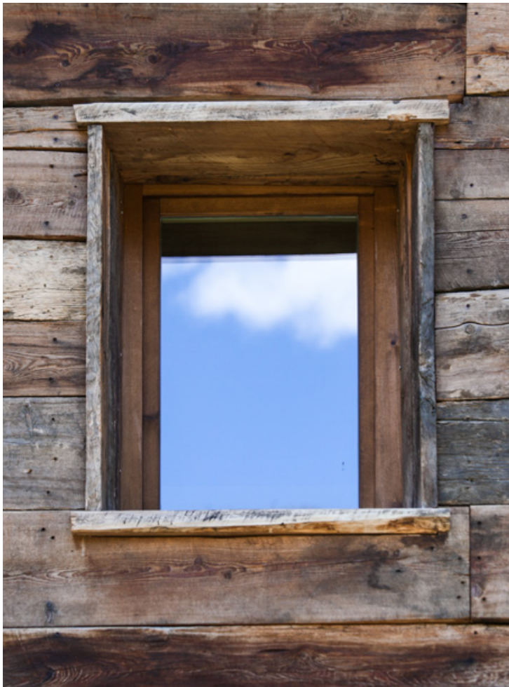
Lou Praije - rénovation - résidence multifamiliale
