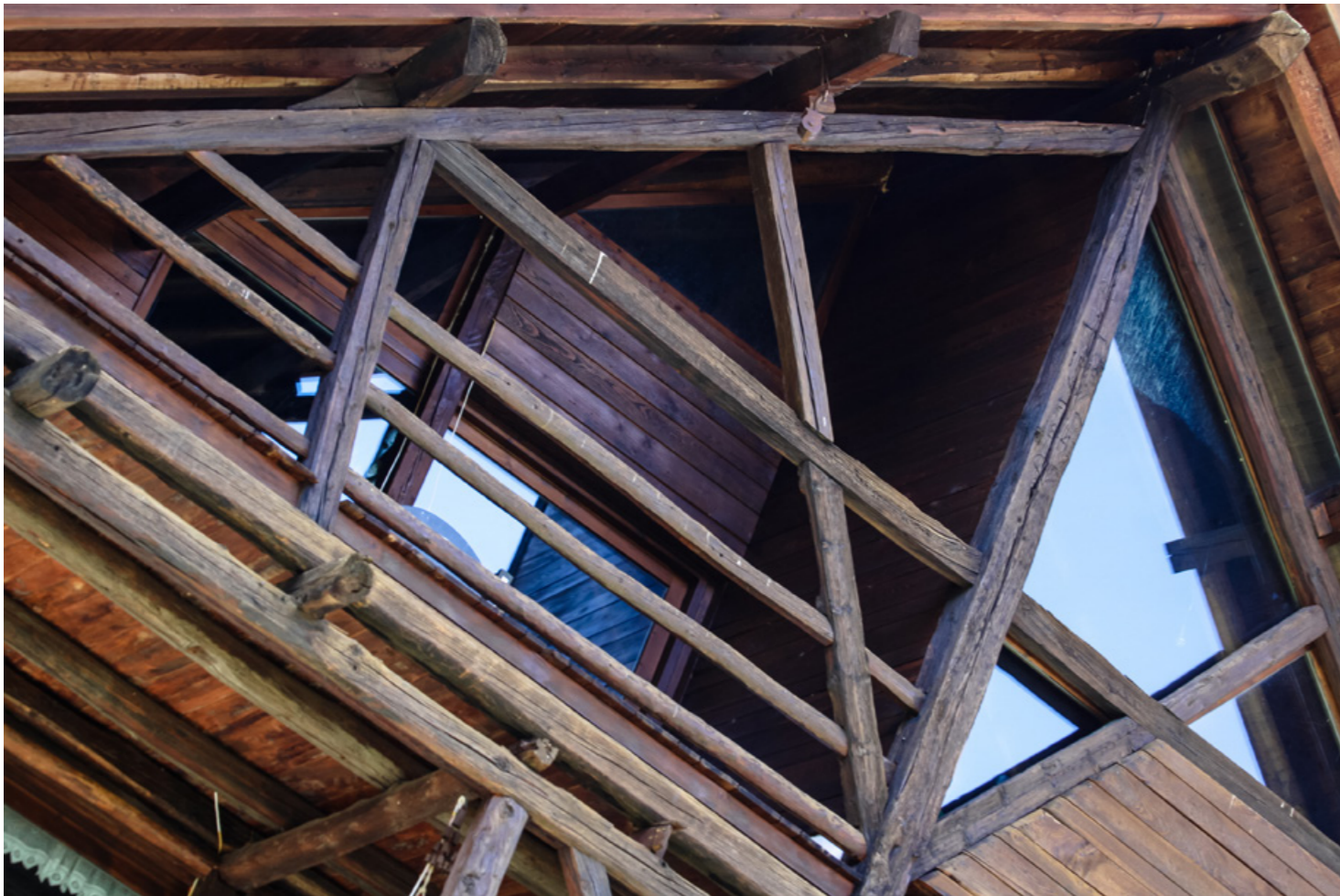
Casa C.F. - rénovation - résidence unifamiliale
