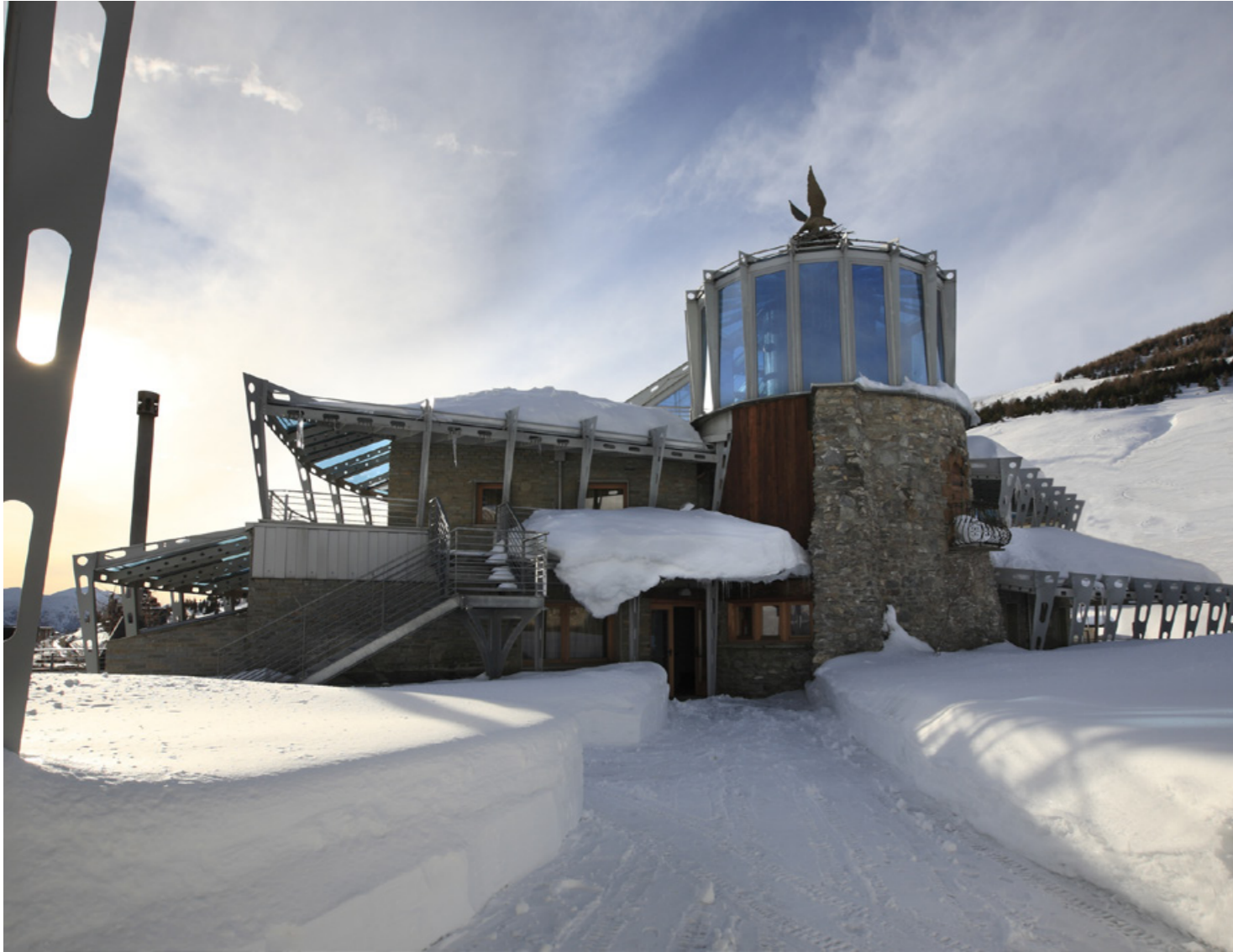
Shakleton hotel - nouvelle construction - hotel ****
