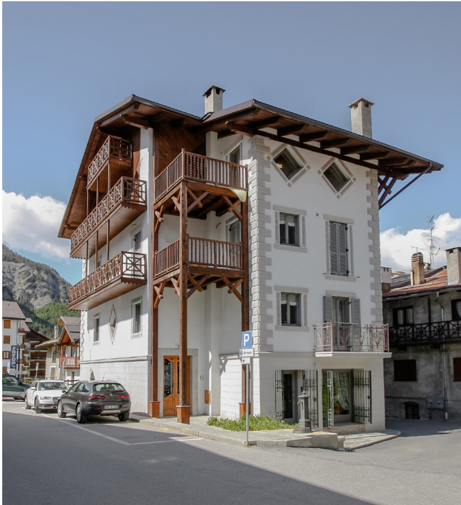
Q.R.T. - rénovation - résidence multifamiliale
