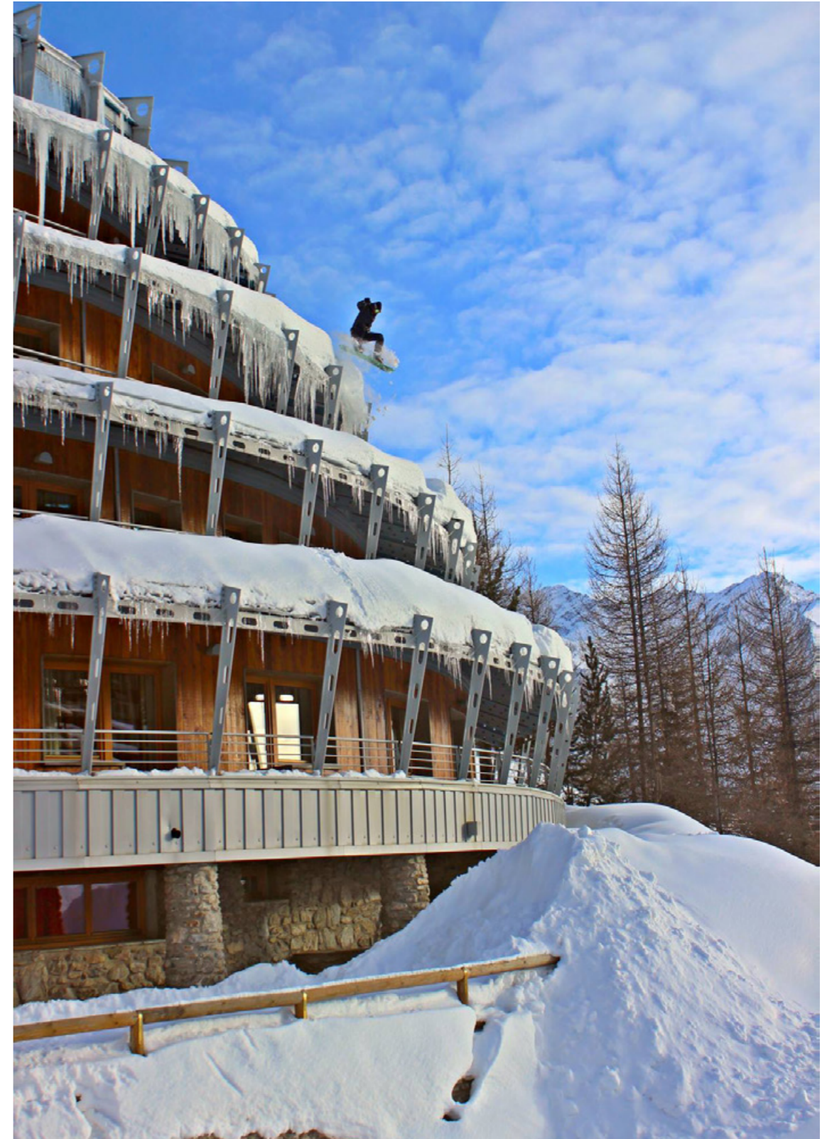
Shakleton hotel - nouvelle construction - hotel ****
