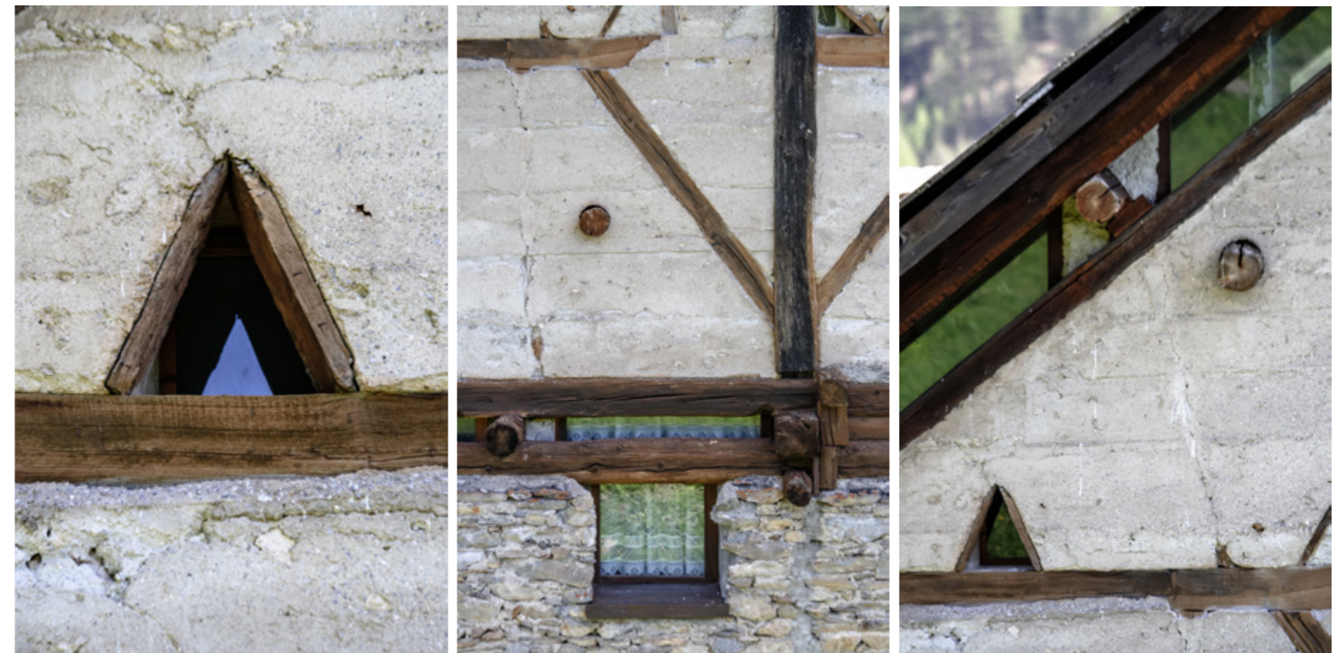
Casa C.F. - rénovation - résidence unifamiliale
