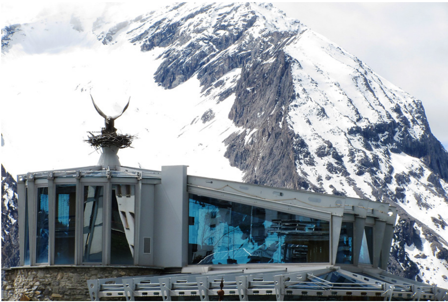
Shakleton hotel - nouvelle construction - hotel ****
