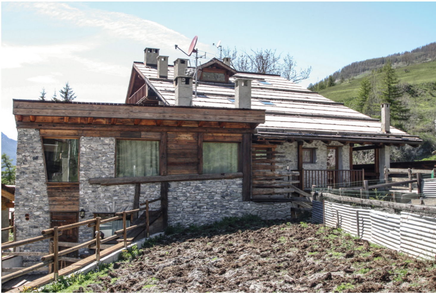
Lou Praije - rénovation - résidence multifamiliale
