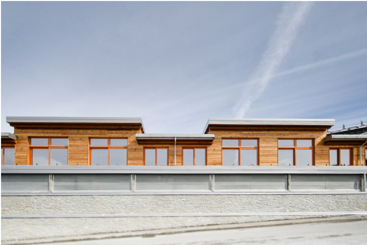
R23 - nouvelle construction - centre commercial et residence multifamiliale
