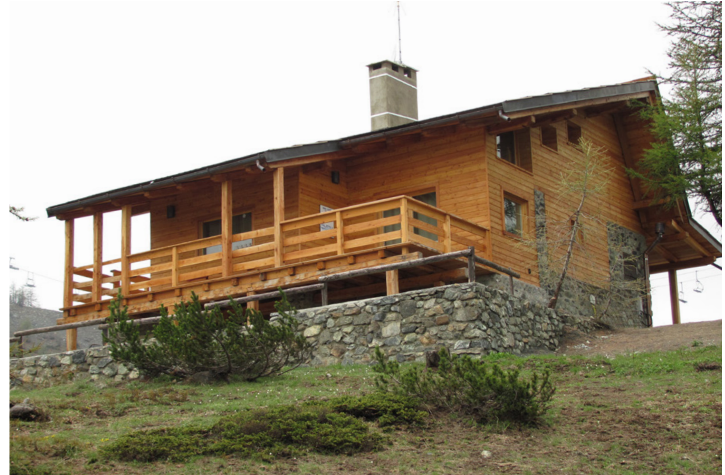
Chalet Fiore - nouvelle construction - résidence unifamiliale
